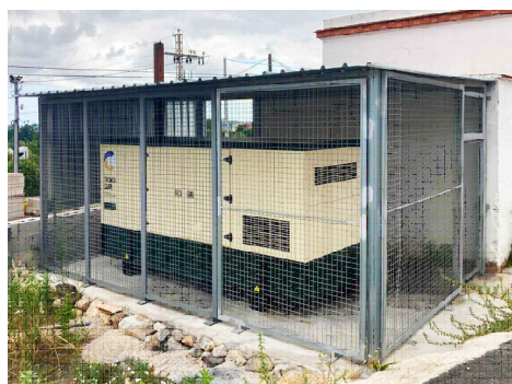
Estructura metálica proyectada con cubierta de chapa y vallado metálico
